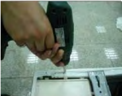
Démonter la trappe d'accès
