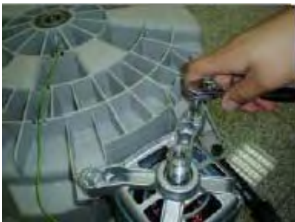
Démonter le moteur
